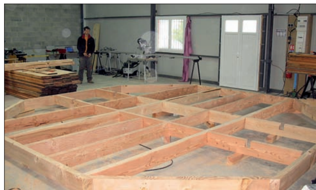
Les armatures sont en construction.
